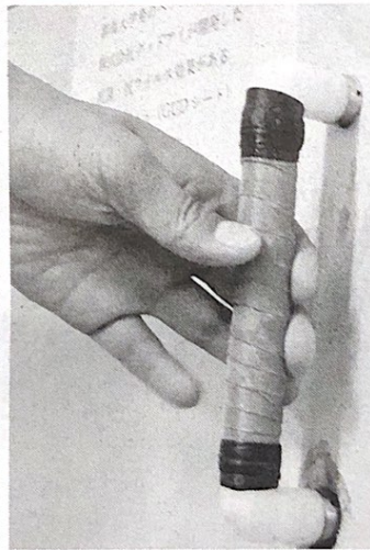
桐生市役所本館トイレのドア内側の取っ手に設置された銅繊維シート
